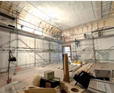
Baustelle Unteres Belvedere
